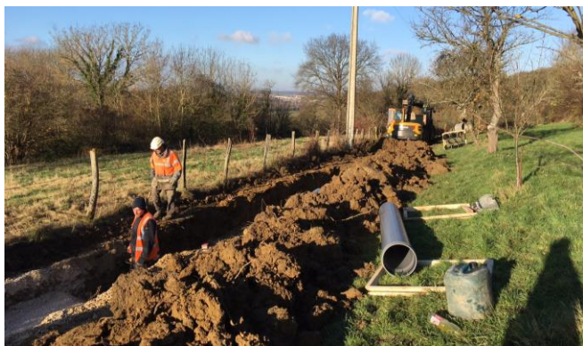
Pose d'une tranchée drainante chemin du Rouot
