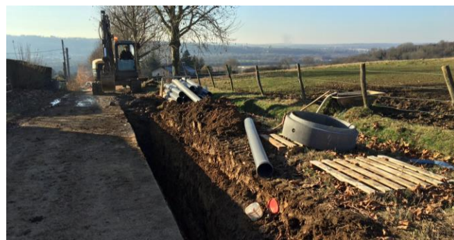
Réseau d'assainissement rue du Sorbier
