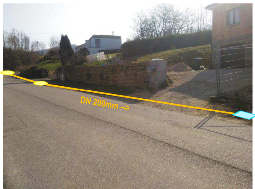
Figure 18 : exemple de réalisation de la pose du réseau sous accotement
